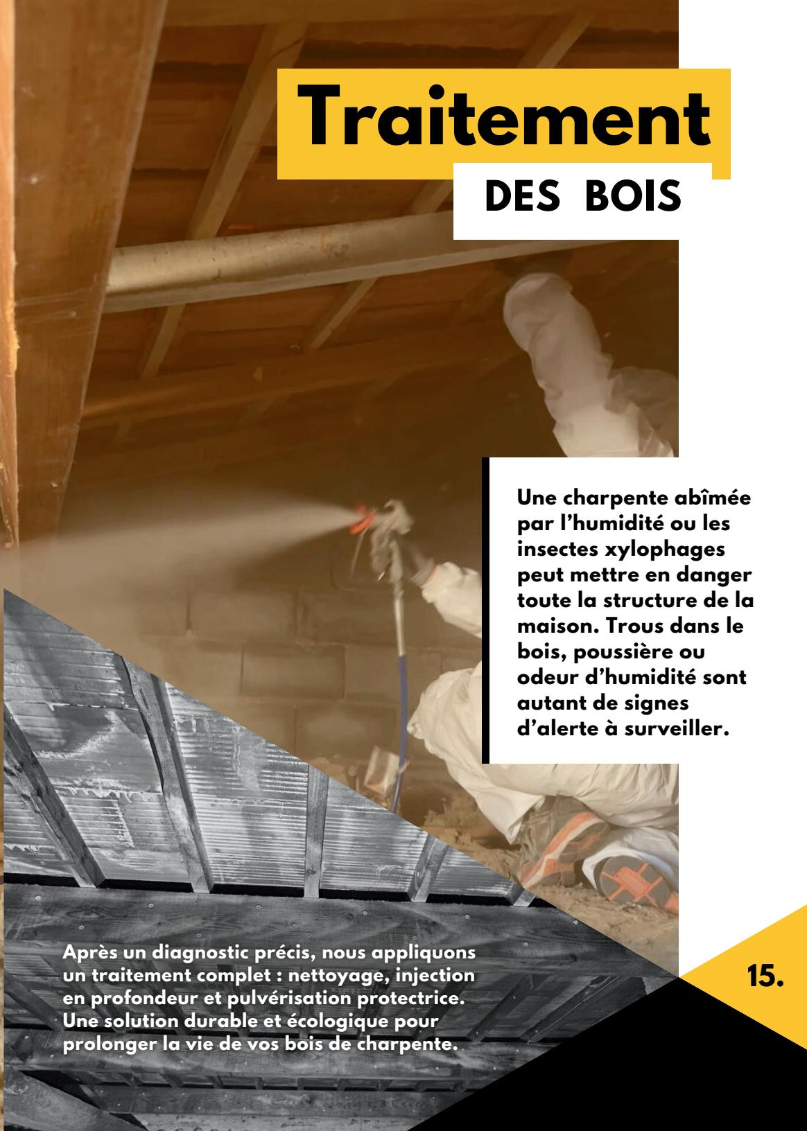
Une charpente abîmée par l'humidité ou les insectes xylophages peut mettre en danger toute la structure de la maison. Trous dans le bois, poussière ou odeur d'humidité sont autant de signes d'alerte à surveiller.
